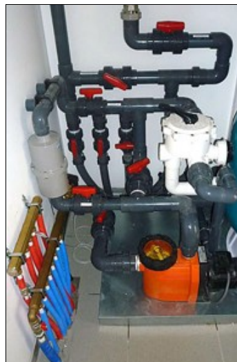
Filtersysteem voor zwembadwater
