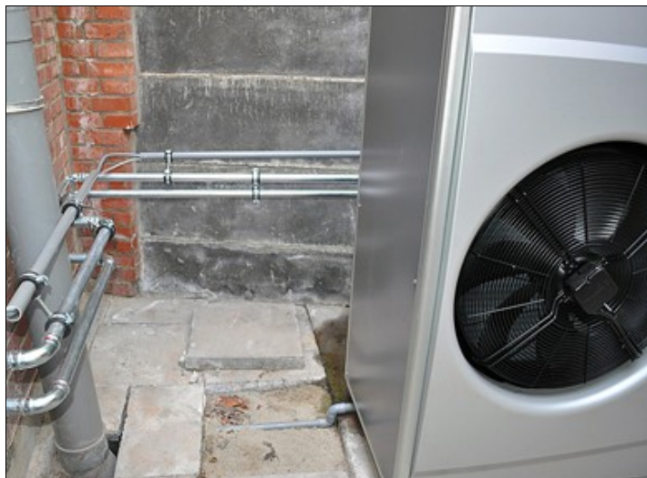
De ventilator werd op een overdekte plaats gezet met direct contact met de buitenlucht
