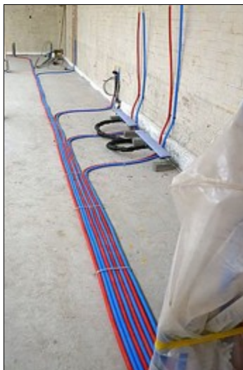
Vorbereiding van de doucheruimte
